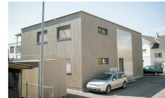
**Der Sockel** der aus vorgefertigten hölzernen Modulen gebauten Kleinwohnanlage ist betoniert. Im ebenfalls hölzernen Verschlag links vom Haus ist Platz für Fahrräder der Bewohner bzw. wird Müll deponiert.
