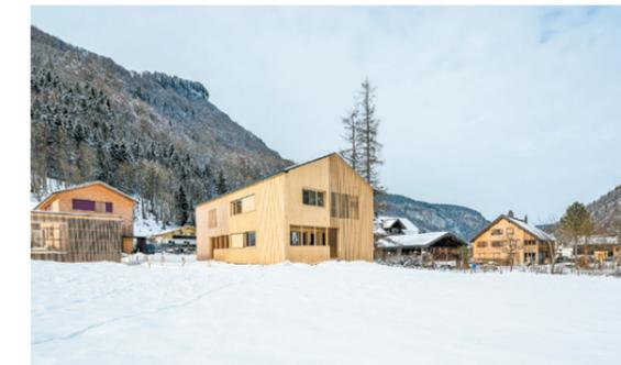
**Anreise** Ein Holzscreen aus vertikal verlaufenden Lamellen bietet beim Schopf einen konstruktiven Sonnenschutz und verhindert Einblicke.
