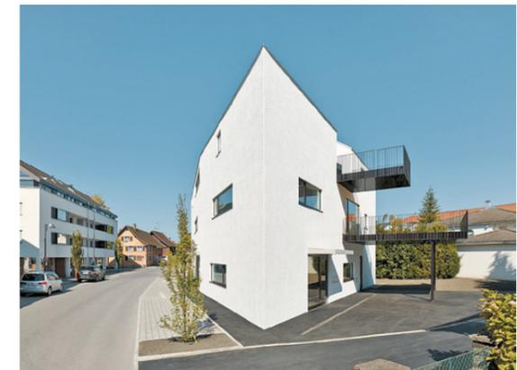
**Betonkern** Rund um einen Betonkern, in dem sich auch das Stiegenhaus befindet, ist das Haus Immler aus Ziegeln gebaut, die außen mit einer acht Zentimeter dicken Dämmung versehen sind.
