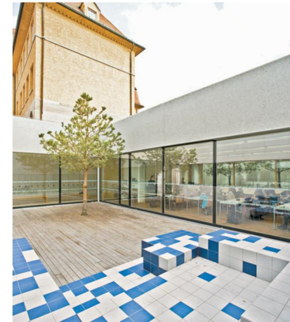
**Aus gestocktem Beton** sind die Hofwände, was an den Stampfbetonsockel des Altbaus erinnert.
