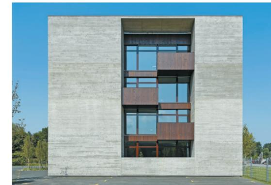
**Der verglasten Bürowand** nach Süden vorgelagert spendet eine massive Holzkonstruktion Schatten und verleiht dem Bau Maßstab und Plastizität.
