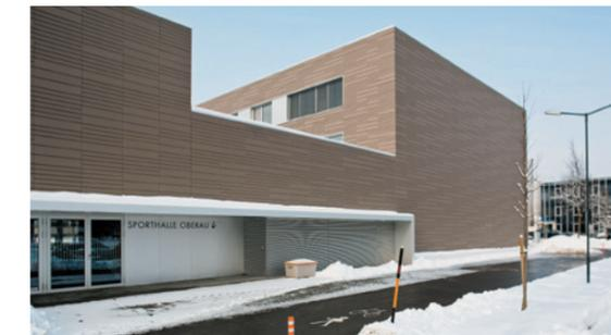
**Ergänzen** Brücken verbinden die einzelnen Baukörper auf der Ebene des Obergeschoßes. Das Fassadenbild von VS und HS blieb erhalten. Nur die Fenster wanderten nach außen in die neue Dämmebene. So gibt's innen praktische Fensterbänke und etwas mehr Platz.
