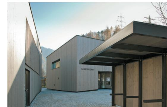
**Die Rückseite des Feuerwehrhauses** - offen zum Ausrücken. Und der Schlauchturm mit Photovoltaik zur Unterstützung der Wärmepumpe.
