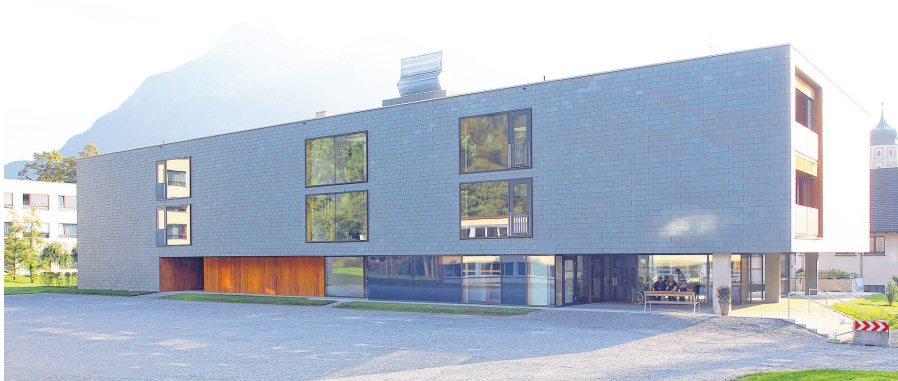
Nach Norden haltbare Schieferschindeln und große Fenster für die Gangzonen, die Parkgestaltung ist in Arbeit.
