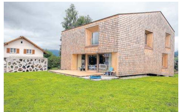
Der gelochte Carport setzte den Anfang des Bauprojekts.
