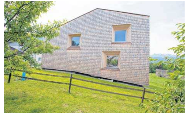
Gut geschnitten ist die neue Hülle aus Stroh und Schindeln.
