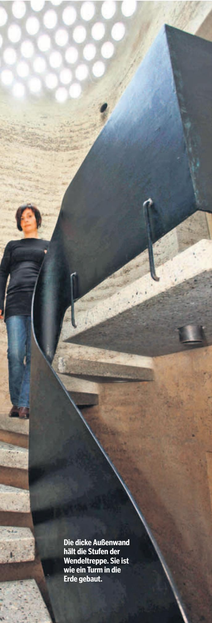
Die dicke Außenwand hält die Stufen der Wendeltreppe. Sie ist wie ein Turm in die Erde gebaut.
