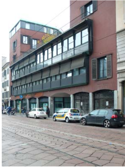
24 Wohn- und Geschäftshaus, 1957–64 Mailand, Corso Italia 22–24
