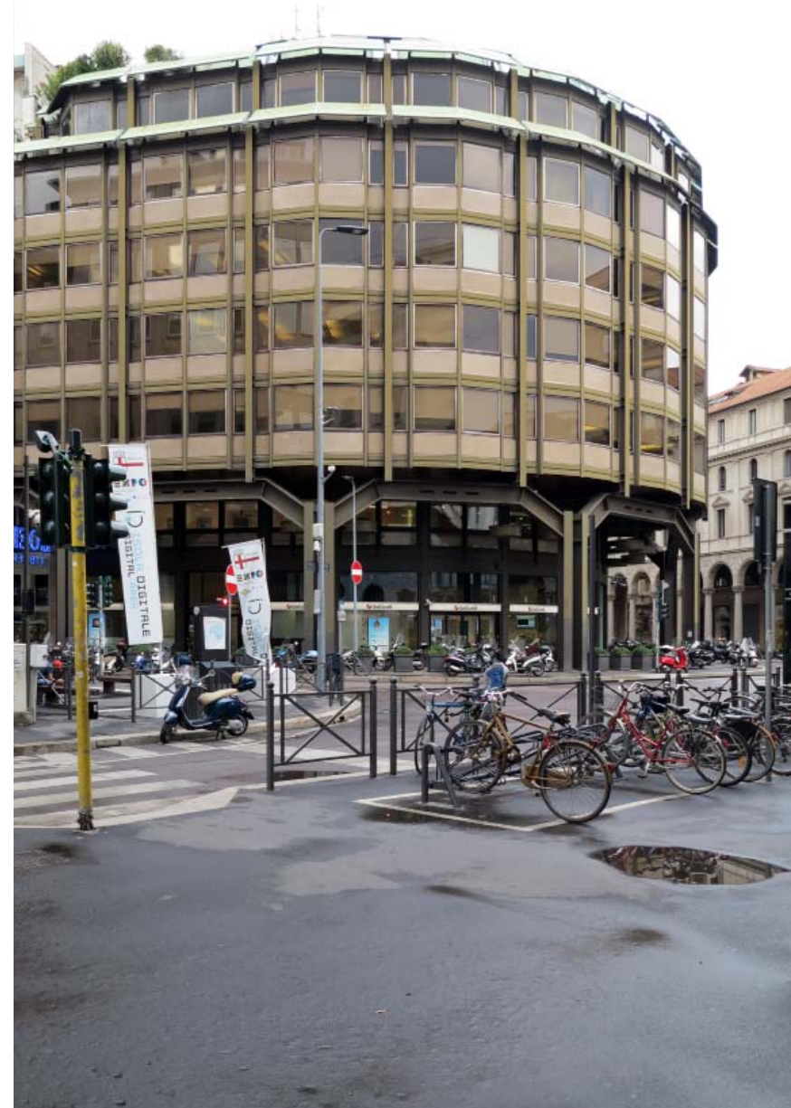
14 Bürohaus, 1958–69 Mailand, Via Ulrico Hoepli 7, Piazza Filippo Meda
