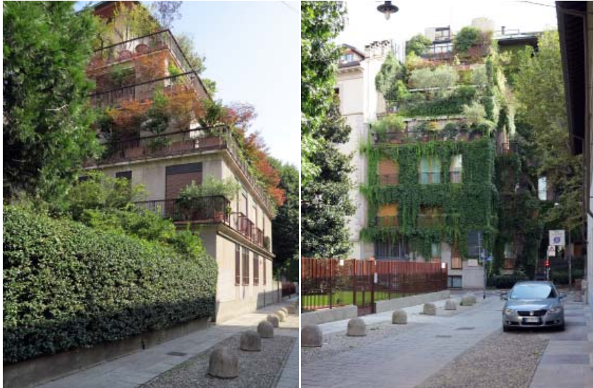
11 Terrassenhäuser, 1961–70 Mailand, Via Cavalieri del Santo Sepolcro 10–12
