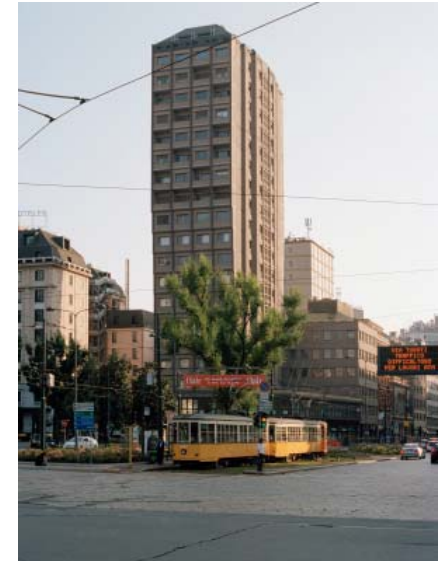
55 Torre Turati, 1966–69 Mailand, Piazza della Repubblica, Via Turati
