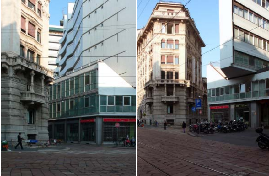
51 Büro- und Wohnhaus, 1949–56 Mailand, Corso Italia 13, Via Rugabella
