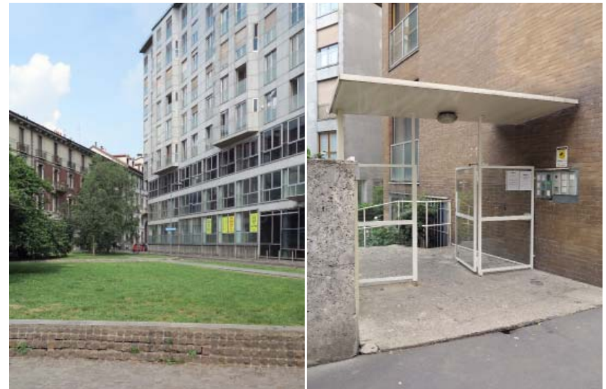
2 Wohn- und Bürohaus, 1969 Mailand, Piazza Santissima Trinità 6, Via Giannone 9
