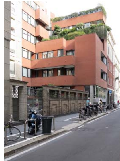
41 Wohnhaus, 1966 Mailand, Via del Conservatorio 22
