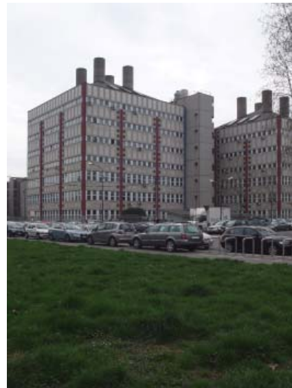
43 Fakultätsgebäude, 1978–82 Mailand, Via Giovanni Celoria 26
