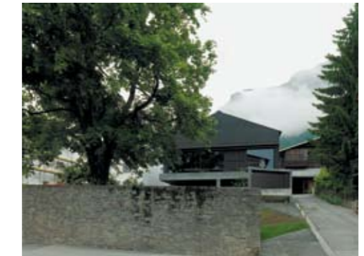
^8_Flims: Wo der Stall aus Holz war, steht das Atelier aus Beton. Architektur: Valerio Olgiati, Foto: Archive Olgiati
