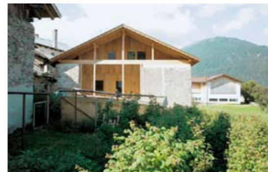
^18_St. Valentin: Umbau statt Abbruch zugunsten eines kanadischen Blockhauses.
