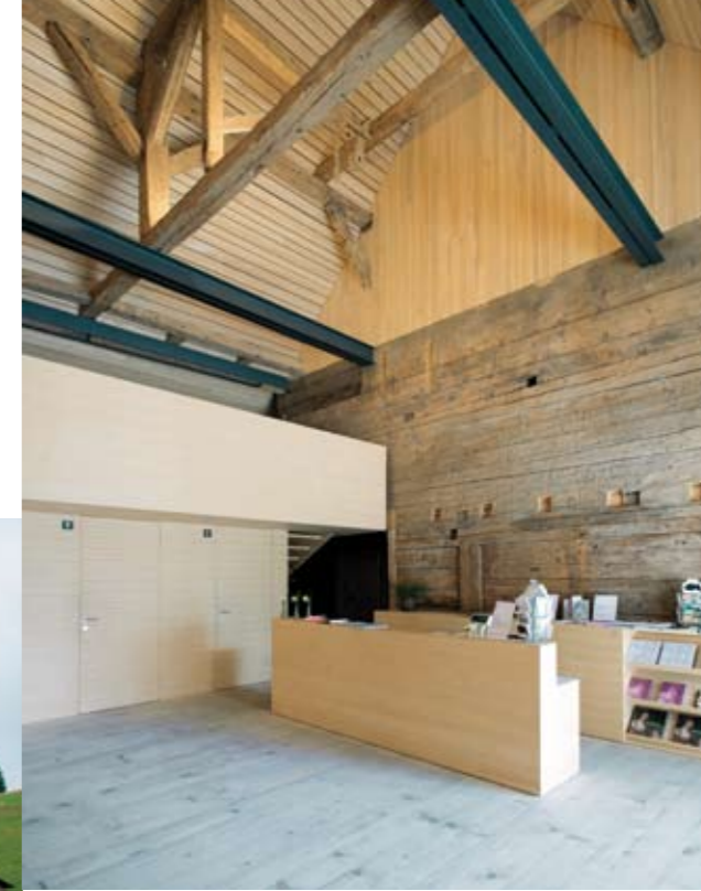
<21_Der Heustall, Stahlträger verstärken die Holzbalken.
