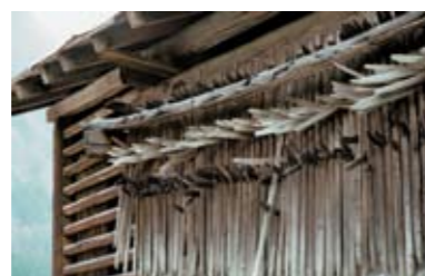
<23_Heinzengerüst am Heulager.
