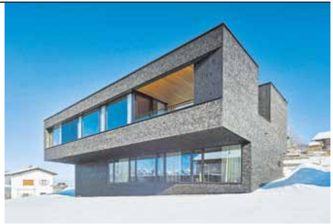
Bauherr: Anonym Planung: architektur.terminal Hackl und Klammer, Rötis Ausführung: Summer Holzbau GmbH, Rötis und Baumeister Ing. Peter Keckeis GmbH & Co. KG, Rötis
