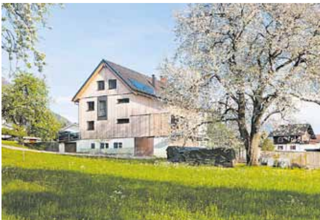
Bauherr: Bernhard und Elisabeth Dressel, Nüziders Planung: ff Bauleitungsbüro GmbH, Andelsbuch Ausführung: Zimmerei Berchtel GmbH, Schnifis
