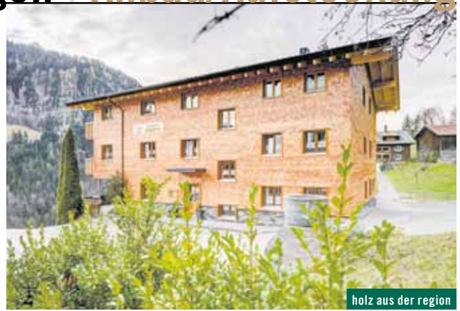
Bauherr: Ida und Simon Kathan, Sonntag Planung: Christian Heim, Thüringen Ausführung: Zimmerei Heiseler GesmbH & Co. KG, Sonntag
