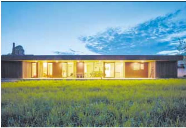
Bauherr: Mona Franke und Gerold Rudisch, Hörbranz Planung: Christian Walch, Nüziders und Birgit Dreyer (D) Ausführung: Alpina Hausbau GmbH, Hard
