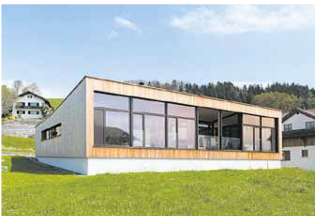
Bauherr: Wilfried Breuß, Übersaxen Planung: Architekturbüro DI Klaus Wanko, Feldkirch Ausführung: Zimmerei Berchtel GmbH, Schnifis
