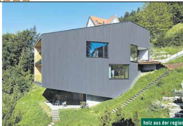
Bauherr: Stephan Schnell und Bettina Siess, Bregenz Planung: Dietrich I Untertrifaller Architekten ZT GmbH, Bregenz Ausführung: Kaspar Greber Holz- und Wohnbau GmbH, Bezau und Erich Moosbrugger Bau GmbH, Andelsbuch
