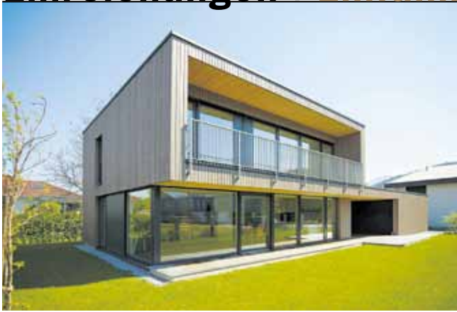
Bauherr: CW, Feldkirch Gisingen Planung: DI Hebein Udo, Schwarzach Ausführung: Berchtold Holzbau Wolfurt GmbH & Co. KG, Wolfurt
