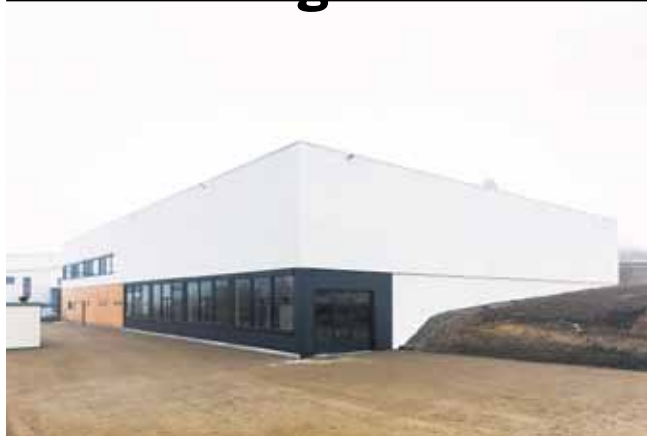
Bauherr: Vaude Sport GmbH & Co. KG, Tettwang-Obereisenbach Planung: Architekturbüro Wilhelm, Renchen Ausführung: Sohm HolzBautechnik GmbH, Alberschwende und Rhomberg Bau GmbH, Bregenz
