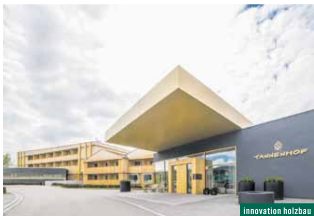
Bauherr: Familie Langes, Weiler Planung: Architektur Jürgen Hagspiel, Lingenau Ausführung: Zimmerei Gerhard Bilgeri, Riefensberg
