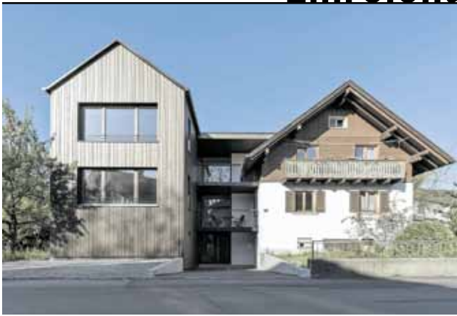
Bauherr: Erna Dür und Laura Jiricka, Schwarzach Planung: querschnitt pro12 GmbH DI Reinhard Weber, Wolfurt Ausführung: H. Böhler GmbH, Wolfurt
