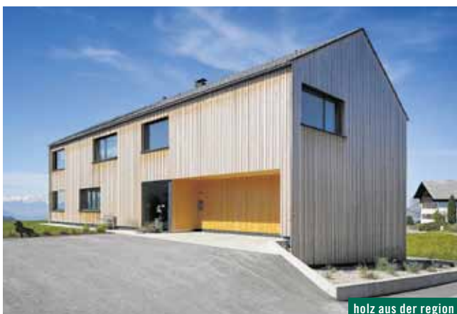
Bauherr: Familie Willi, Bildstein Planung: Architektur Jürgen Hagspiel, Lingenau Ausführung: Sohm HolzBautechnik GmbH, Alberschwende
