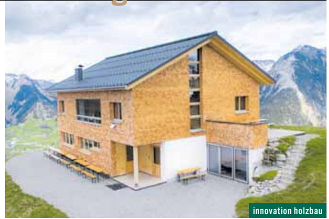
Bauherr: Bitsche-Holding, Thüringen Planung: Dipl. Ing. Gottfried Partl, Thüringen Ausführung: Burtscher Holzbau, Ludesch und Zimmerei Heiseler GesmbH & Co. KG, Sonntag
