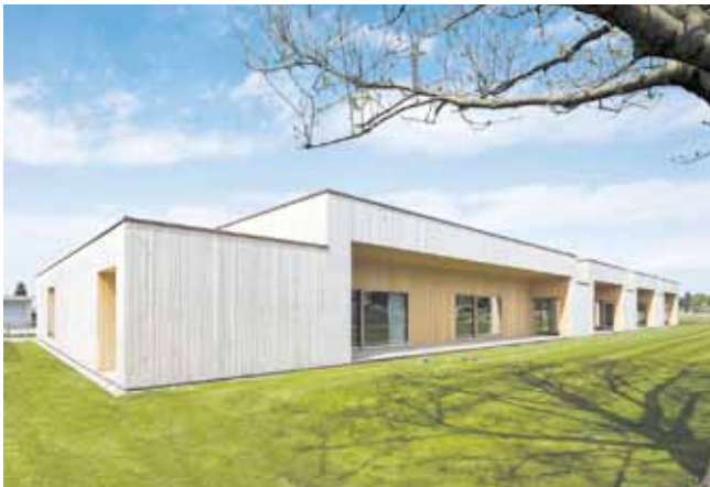
Bauherr: Marktgemeinde Lauterach Planung: Architekt Bernardo Bader ZT GmbH, Dornbirn Ausführung: i+R Holzbau GmbH, Lauterach
