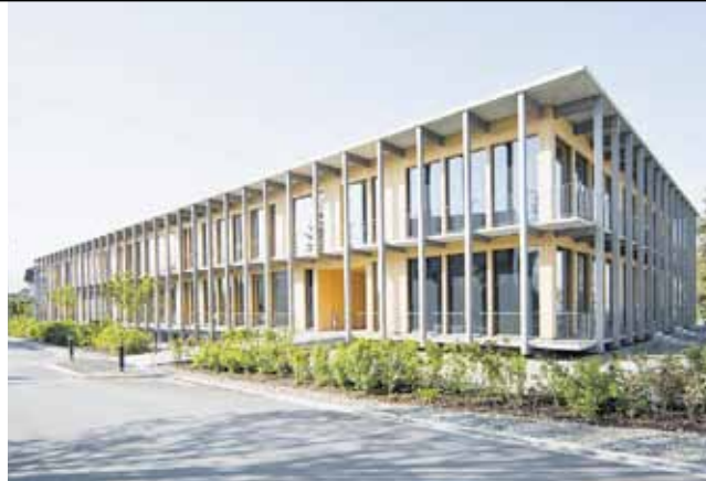
Bauherr: Politische Gemeinde Widnau Planung: Hutter Nüesch Architekten AG, Berneck Ausführung: Sohm HolzBautechnik GmbH, Alberschwende
