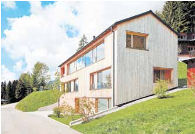
Bauherr: Anonym Planung: Bechter Zaffignani Architekten ZT GmbH, Bregenz Ausführung: Fetz Holzbau GmbH, Egg
