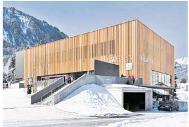
Bauherr: Bergbahnen Mellau GmbH & Co. KG, Mellau Planung: Frick Architekt ZT GmbH, Reuthe Ausführung: Sohm HolzBautechnik GmbH, Alberschwende, Wälderbau Dragaschnig GmbH, Schwarzenberg und Oberhauser & Schedler Bau GmbH, Andelsbuch
