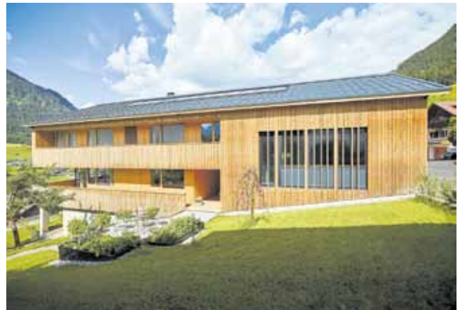
Bauherr: Rosmarie und Bruno Ammann, Au Planung: Archmp Moosbrugger Pfandl ZT GmbH, Dornbirn Ausführung: Holzbau Stephan Muxel, Au
