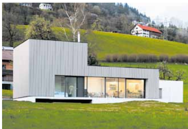
Bauherr: Andrea Exner und Oliver Fischer, Bregenz-Fluh Planung: fischer architektur, Bregenz-Fluh Ausführung: oa.sys baut GmbH, Alberschwende
