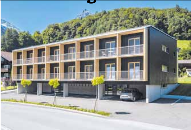
Bauherr: Fritz Holzbau, Bartholomäberg Planung: Dipl. Ing. Hans Hohenfellner, Feldkirch Ausführung: Fritz Holzbau, Bartholomäberg und Biermeier Bau, St. Gallenkirch
