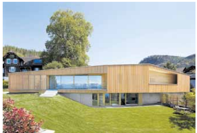
Bauherr: Anonym Planung: Helena Weber Architektin ZT, Dornbirn Ausführung: Dobler Holzbau GmbH, Röthis
