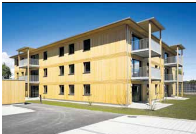
Bauherr: Wohnbauselbsthilfe Vorarlberger gemeinn. reg. Gen.m.b.H., Bregenz Planung: Architekten Hermann Kaufmann ZT GmbH, Schwarzach Ausführung: Sohm HolzBautechnik GmbH, Alberschwende und Feuerstein DER Bau GmbH, Andelsbuch
