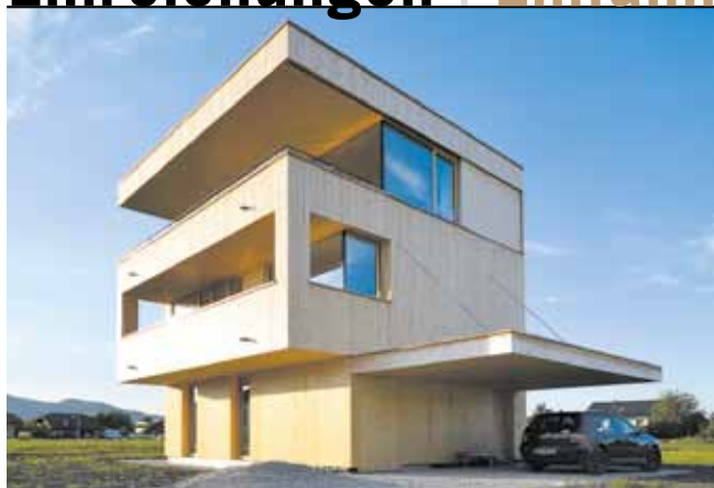
Bauherr: O. Hartmann, Lustenau Planung: k_m architektur, Bregenz Ausführung: Kaspar Greber Holz- und Wohnbau GmbH, Bezau
