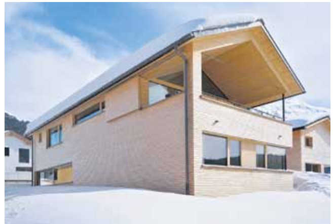
Bauherr: N. Bischof und B. Zweifel Planung: k_m architektur, Bregenz Ausführung: Kaspar Greber Holz- und Wohnbau GmbH, Bezaun
