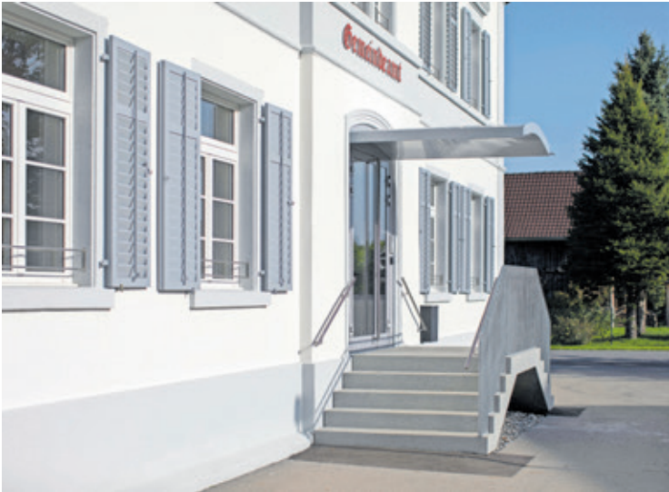
MODERNISIERTER ZUGANG Der Eingang ins Gebäude, ursprünglich auf der anderen Seite, erfolgt über eine neu gestaltete Treppe mit Vordach, die beidseitig begehbar ist.
