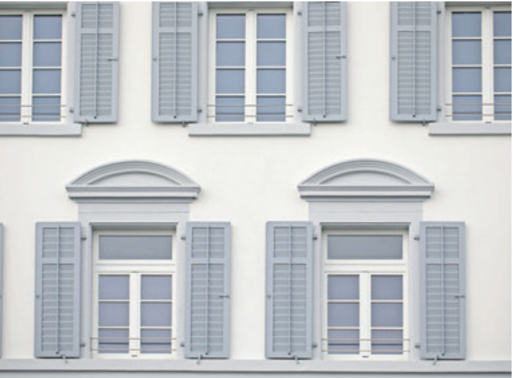
PFLEGELEICHTE FENSTERLÄDEN Die Läden an den Fassaden wurden erneuert, sind jetzt aus Aluminium und damit pflegeleicht und witterungsbeständig.
