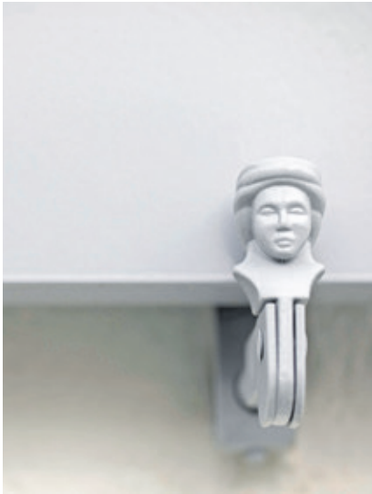
RESPEKT VOR DEM ORT Obwohl keine Denkmalschutzaufgaben bestanden, wurde der historische Charakter bewusst bewahrt.
