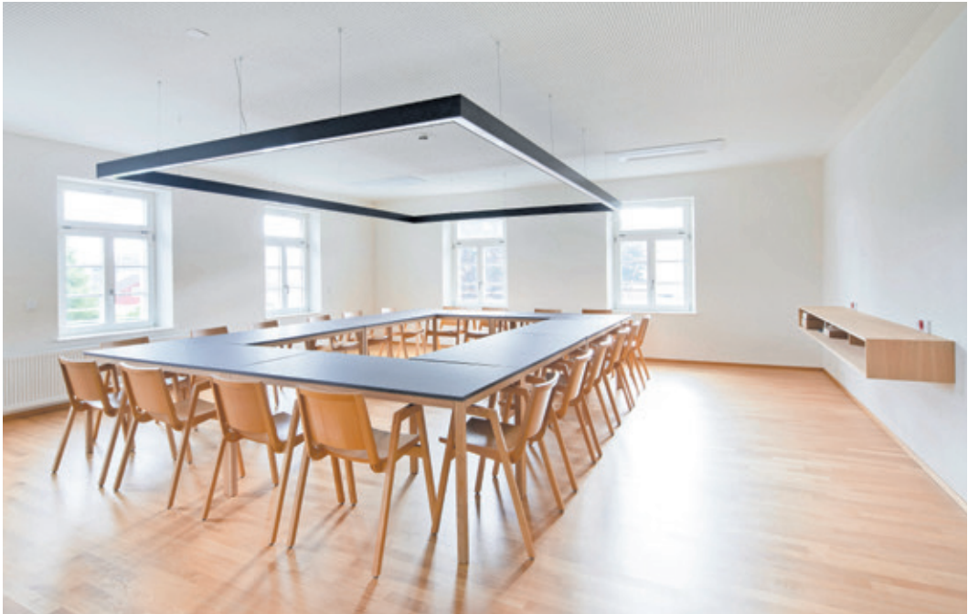
In einzelnen Räumen - im Sitzungssaal im ersten Stock - wurde die Decke geöffnet, wurden Stahlträger eingezogen und die Deckenhöhe des Raumes damit erhöht.
