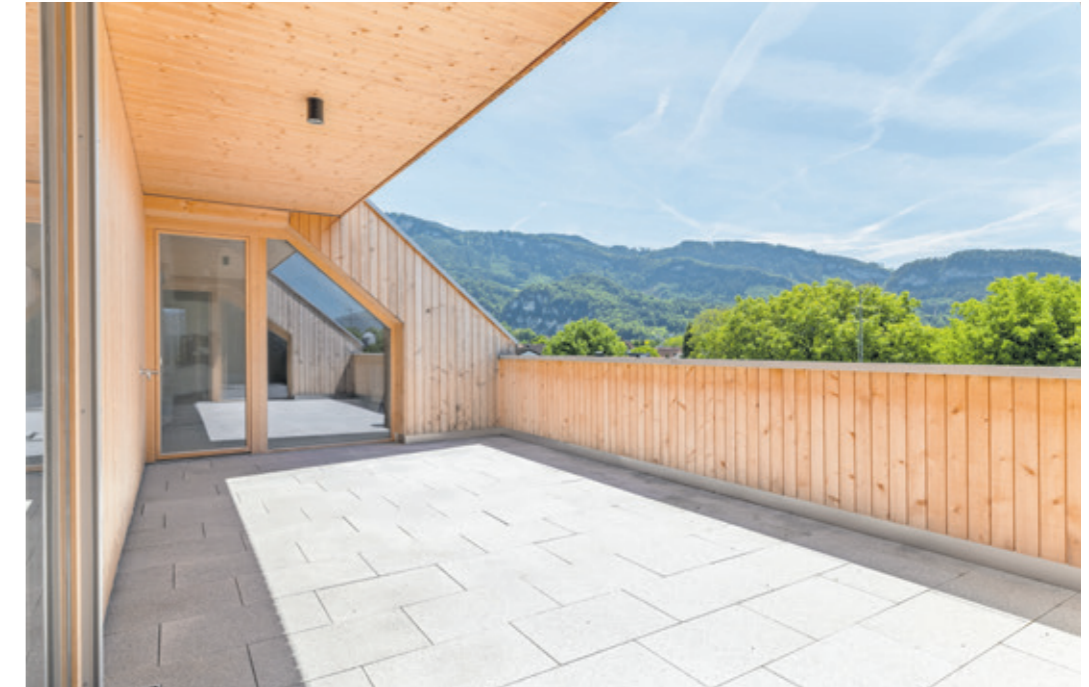
Im Dachgeschoß sind sehr großzügige Terrassen eingeschnitten, von denen man eine großartige Aussicht hat.
