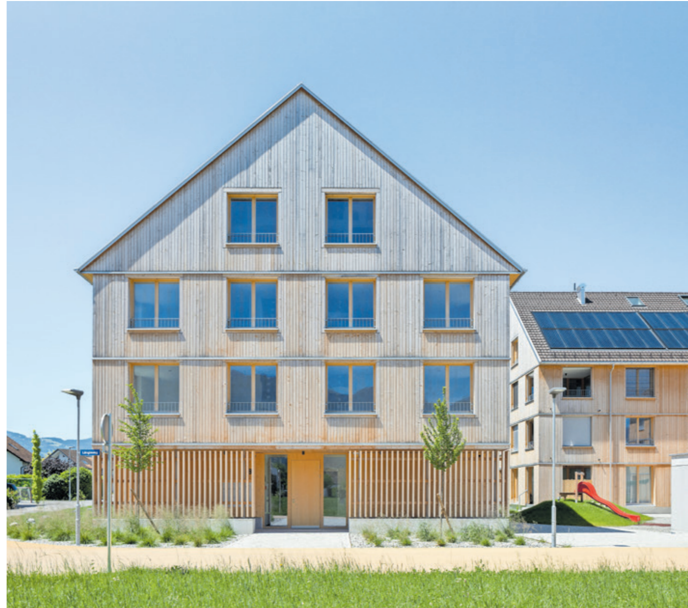
Das Langhaus wird sehr ökonomisch von einem Laubengang erschlossen. Im Erdgeschoß bilden vertikale Holzlamellen, die für Schatten-, Sicht- und Witterungsschutz sorgen, ein vornehmes Entree aus.
