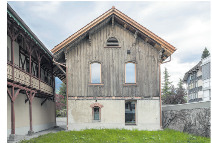
SÜDOSTECKE Über der Erdgeschoßzone in Fachwerkbauweise mit Ziegelmauern ausgefacht, ragt die Holzfassade mit vertikal verlaufenden Brettern in die Höhe. An dieser Ecke versteckt sich hinter dem Fassadenschirm die Veranda.
