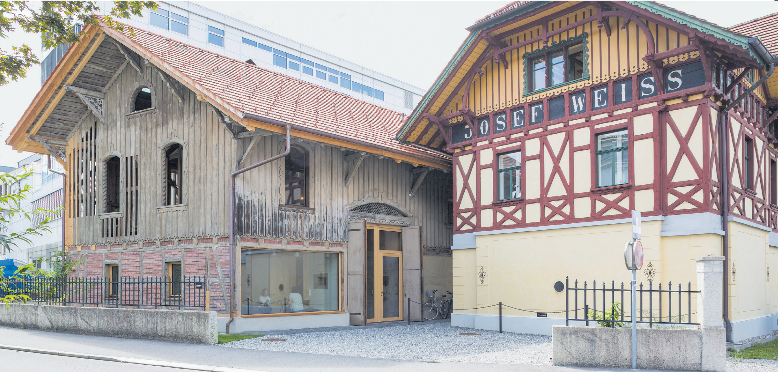
WESTFASSADE Eine neu hinzugefügte Türöffnung erlaubt den direkten Zugang zum Garten, der noch eine ans Haus anschließende Holzterrasse erhält.
