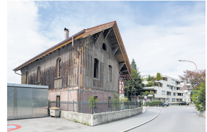
SÜDOSTECKE Über der Erdgeschoßzone in Fachwerkbauweise mit Ziegelmauern ausgefacht, ragt die Holzfassade mit vertikal verlaufenden Brettern in die Höhe. An dieser Ecke versteckt sich hinter dem Fassadenschirm die Veranda.
